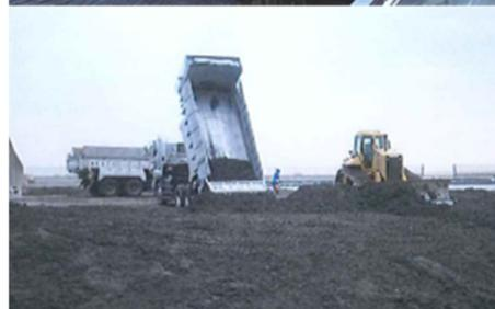
＜中央防波堤外側地区・新海面処分場とダンプトラックによる建設発生土の受入、
